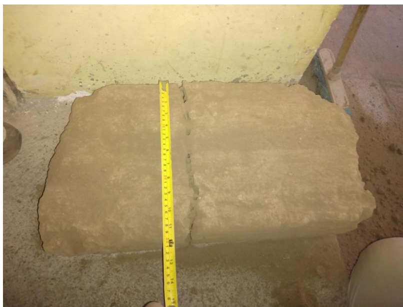
Anexo C1. Extracción de los bloques de adobe de la vivienda patrimonial
