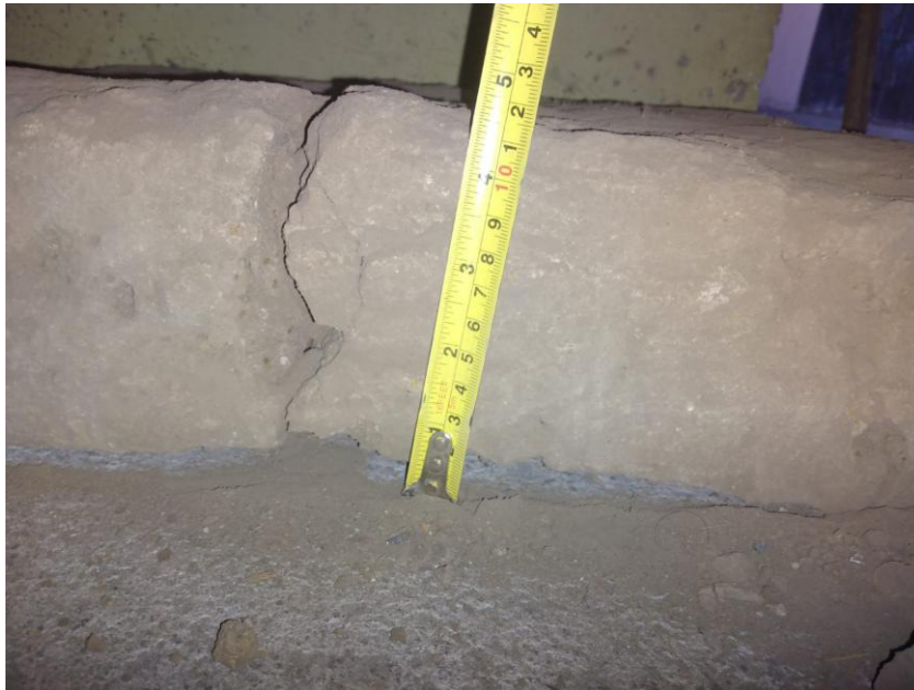
Anexo C3. Extracción de los bloques de adobe de la vivienda patrimonial
