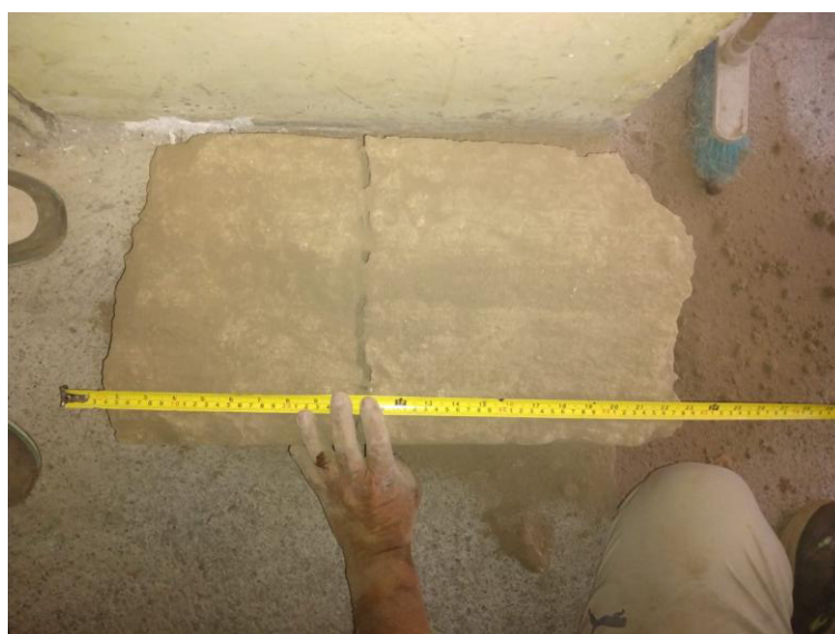
Anexo C2. Extracción de los bloques de adobe de la vivienda patrimonial
