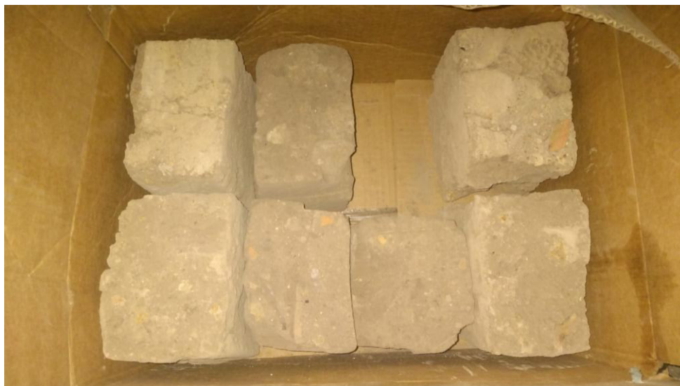
Anexo C4. Extracción de los bloques de adobe de la vivienda patrimonial
