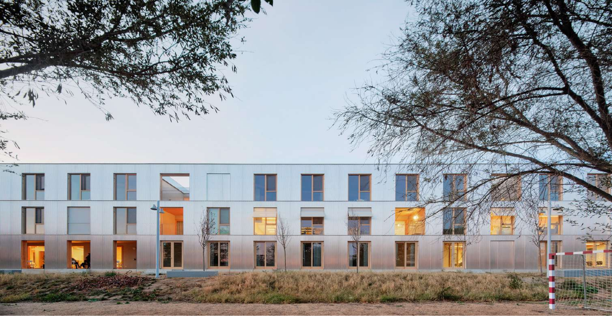
Imagen 32: Fachada Centro Residencial de Primera Acogida Sant Gervasi
