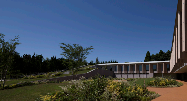
Fig. 69: Fotografía del recorrido en terraza accesible Fuente: arquitecturaviva
