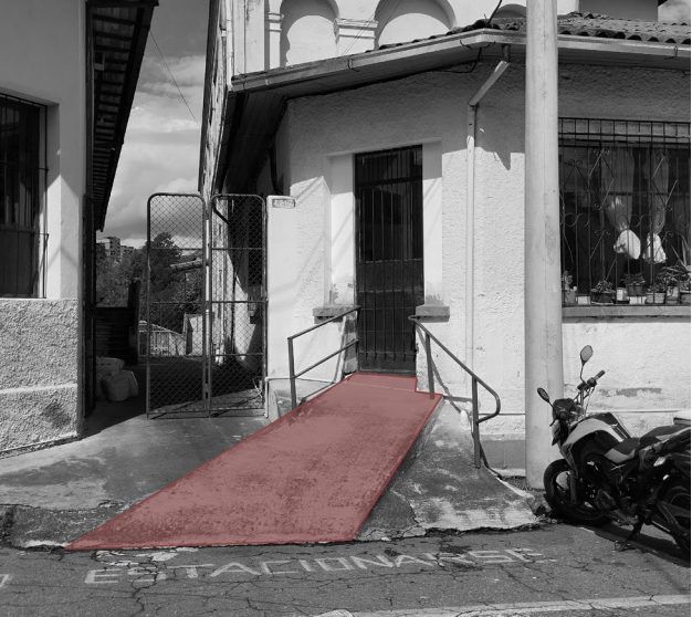
Figura 31. Circulación vertical, rampa. Elaborado por el autor.
