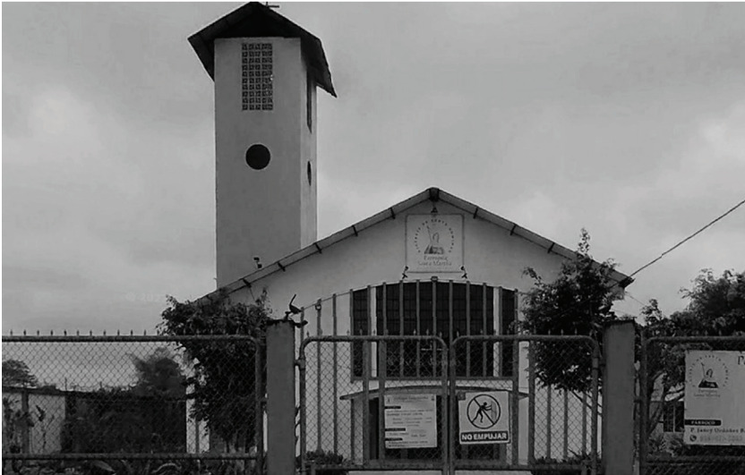
Imagen 45. Fotografía de Iglesia Católica Santa Martha Fuente: Elaboración propia (2025)
