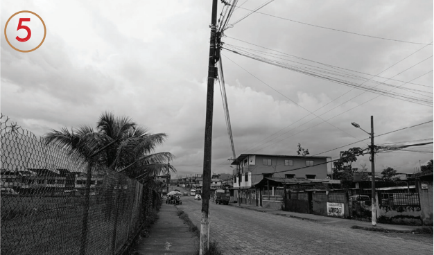
Imagen 14. Recorrido Fotográfico Fuente: Elaboración propia (2025)
