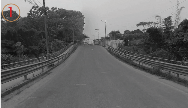
Imagen 11. Recorrido Fotográfico Fuente: Elaboración propia (2025)
