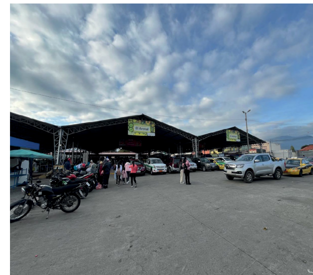
Imagen 1. Fachada Principal Mercado El Arenal. Fuente: Elaboración Propia, 2024.
