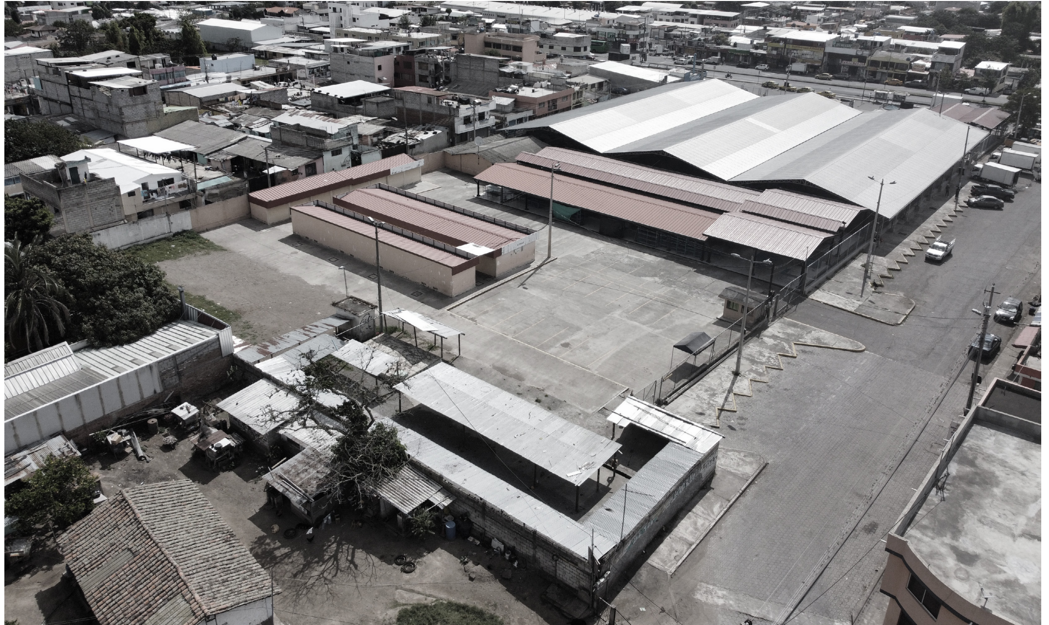
Imagen 17. Fotografía Aérea, Mercado El Arenal Fuente: Elaboración Propia, 2024.
