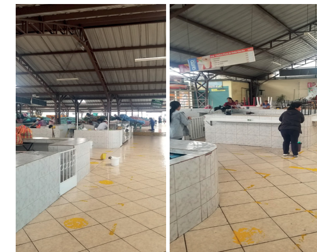
Imagen 4. Situación Interior del Mercado De Tumbaco. Fuente: Elaboración Propia, 2024.
