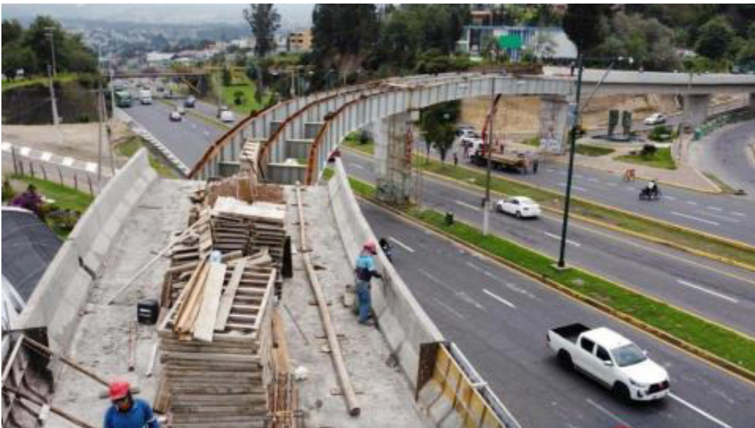
Figura 4 Construcción del Intercambiador de Conocoto
