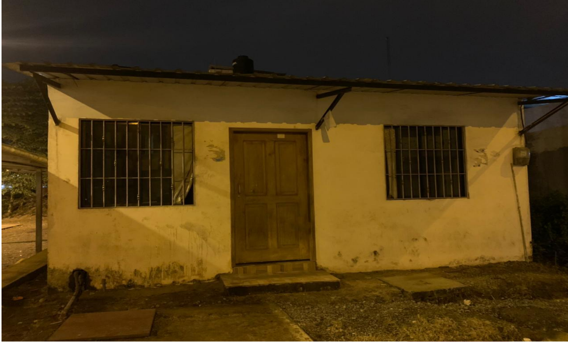
Fotografía N° 7.- Vista de conjunto de la vivienda
