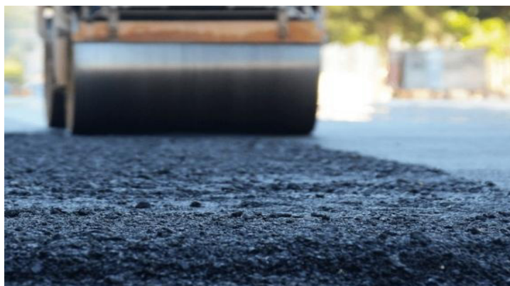
Fig. 3. Maquinaria pesada en reparación vial con asfalto modificado con polímeros SBS. Nota: fuente Chem Fluid.com.
