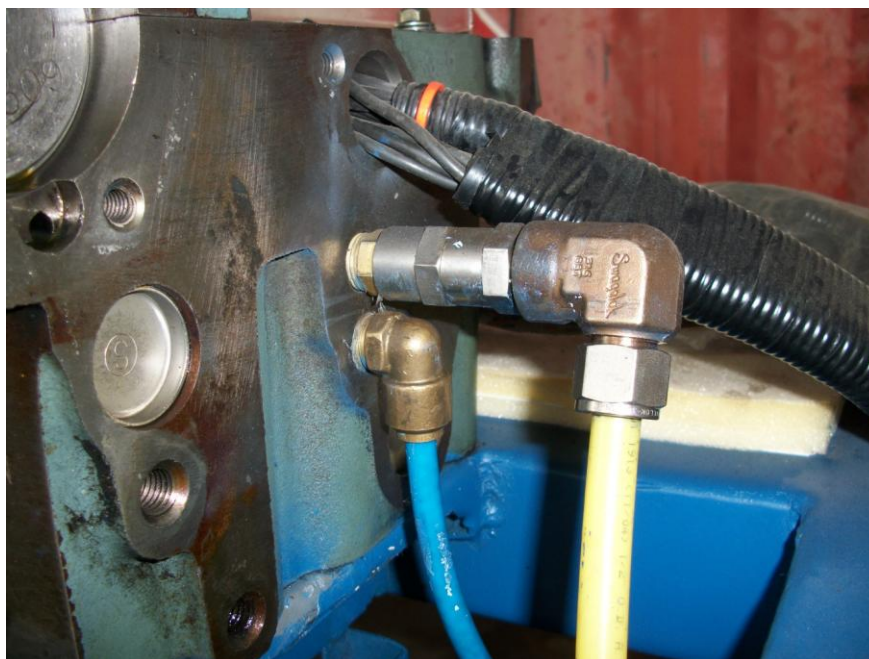
Instalación de los Neplos de entrada y salida de Combustible y Arnés de Cables en la parte posterior del Cabezote
