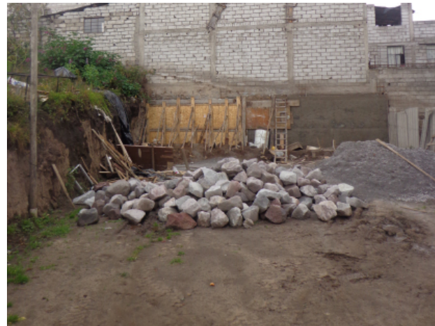
Ilustración 3. Intervención cimientos en terreno para cancha deportiva (Fotografía de autoría propia)
