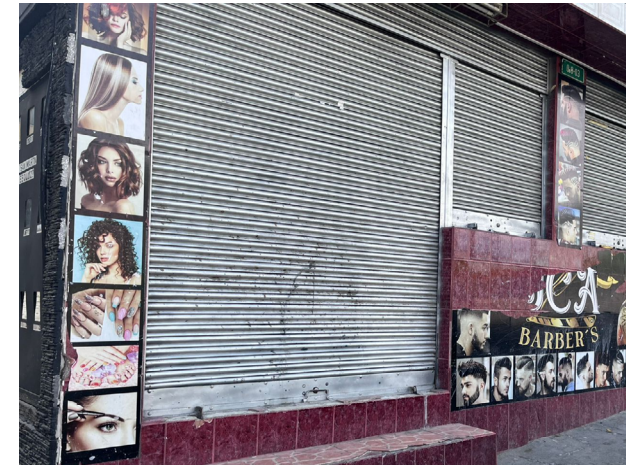
Ilustración 15. Fachada frontal espacio a intervenir Lanfor siempre cerrada (Fotografía de autoría propia)
