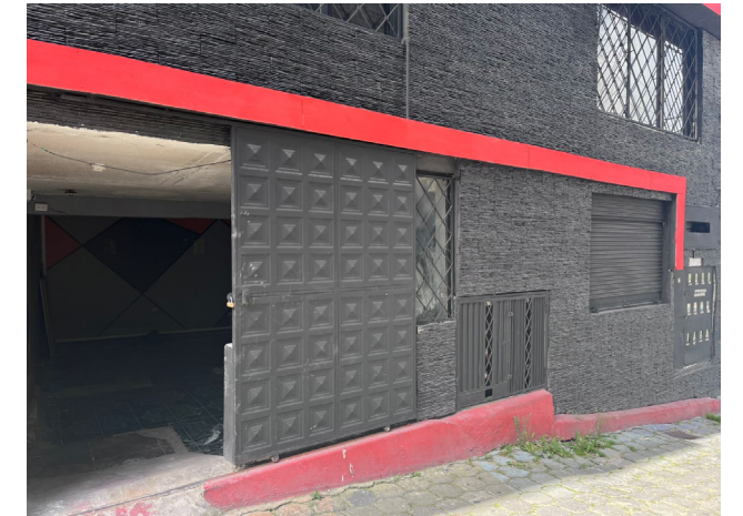
Ilustración 16. Fachada lateral espacio a intervenir. Actualmente estacionamiento de motos exterior (Fotografía de autoría propia)
