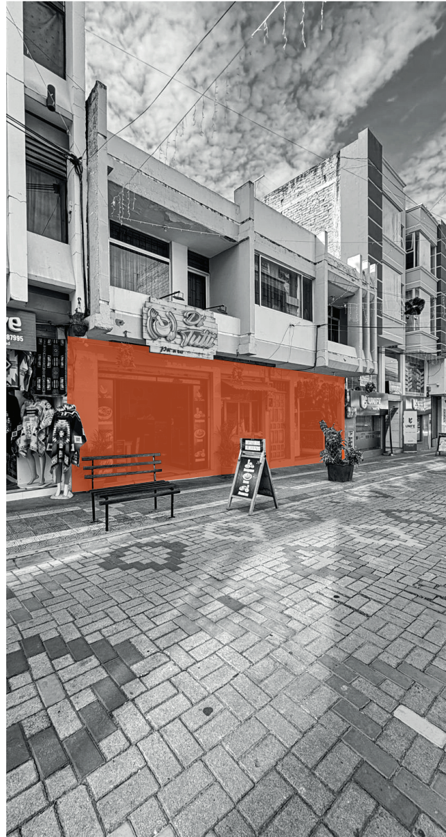
Ilustración 3: Fotografía + Producción Propia- Fachada estado actual
