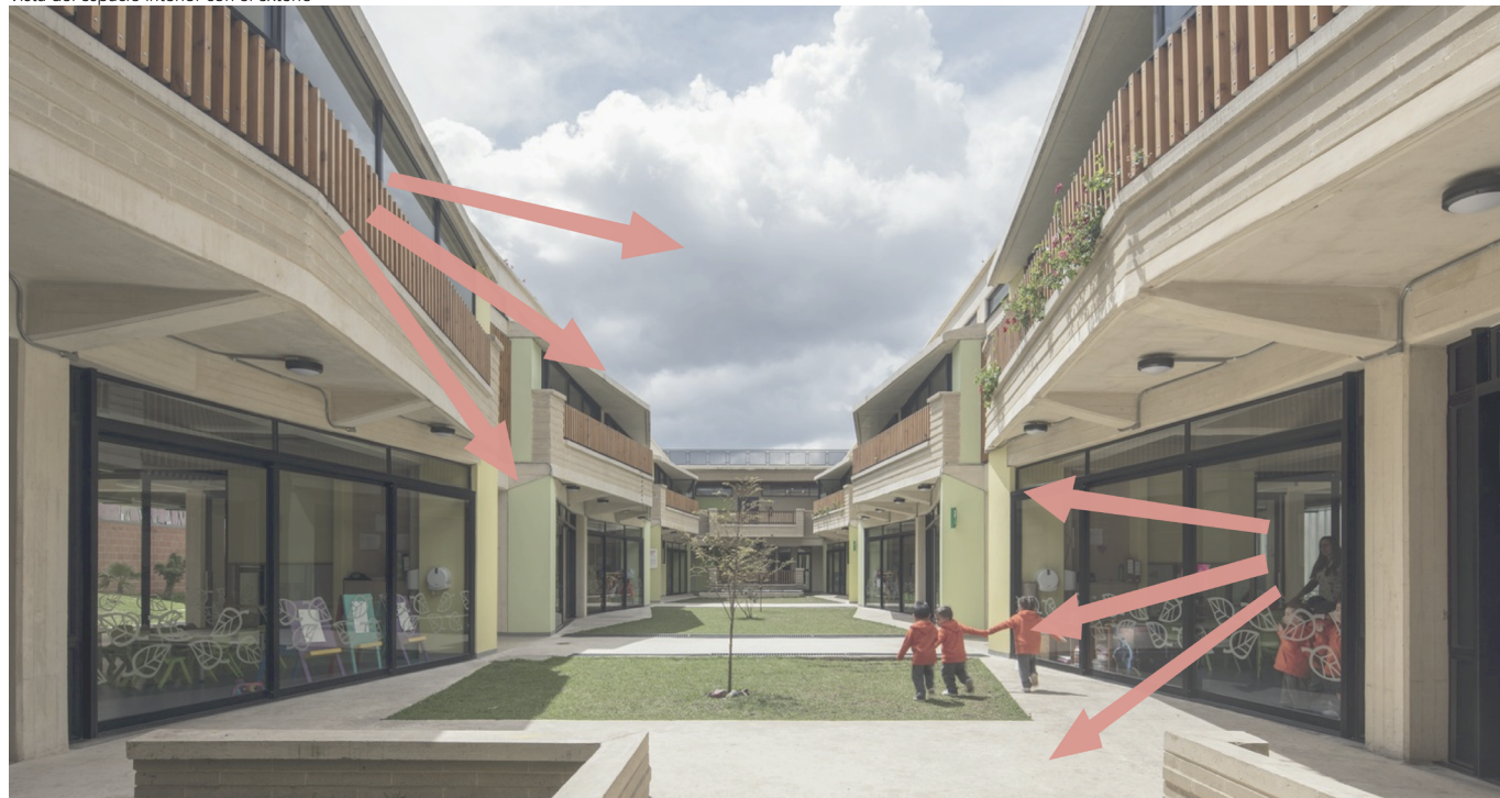
Figura 57: Vista del espacio interior con el exterior
