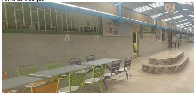
Figura 111: Pasillo del albergue
