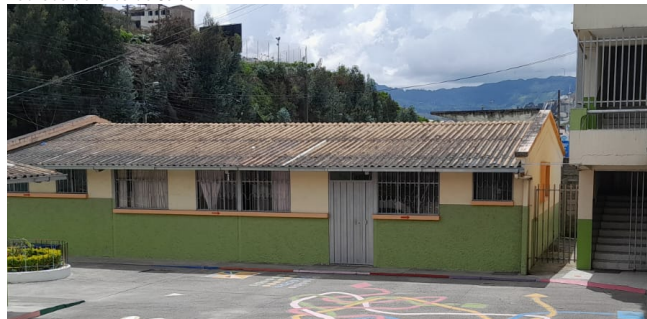
Nota. Se muestra la fachada del área de salud, por la autora, 2025
