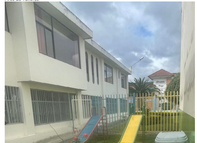
Nota. Fachada frontal del área de los talleres, por la autora, 2025
