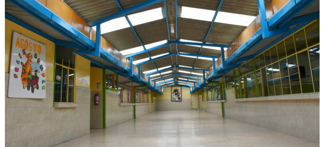
Figura 107: Pasillo del albergue
