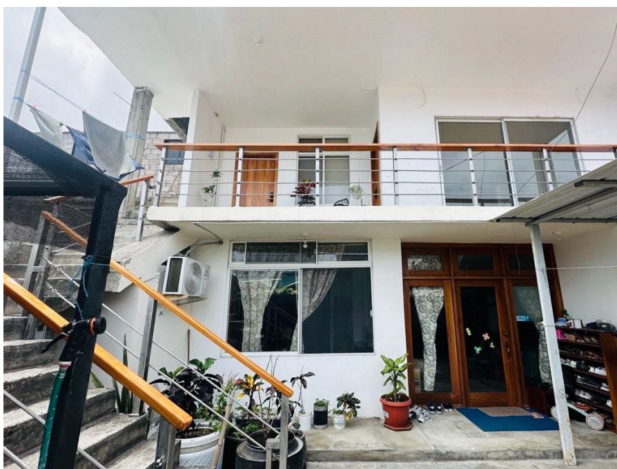
Imagen 8. Pasamanos elaborado con cable de tensión reciclado
