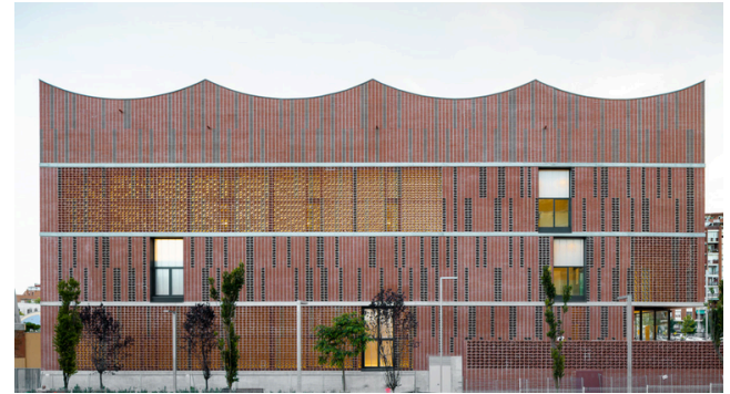
Imagen 37. Fachada del polideportivo Camp Ferro
