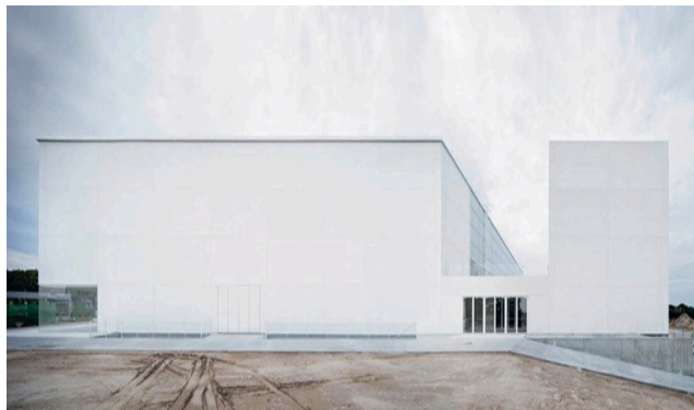
Imagen 48. Fachada del proyecto polideportivo y aulario universidad Francisco de Vitoria
