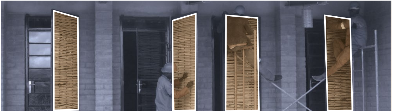
Imagen 30. Colocación de esteras.
