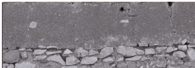
Imagen 11. Cimientos de piedra
