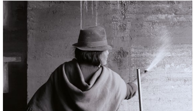
Imagen 8. Muro de tapial
