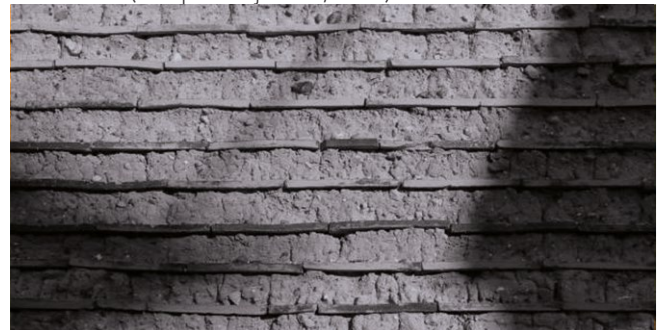
Imagen 9. Muro de Bahareque
