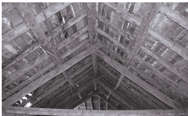
Imagen 10. Estructura de madera
