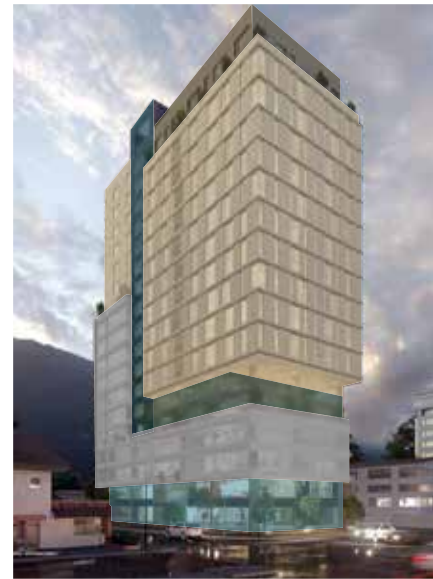
Imagen 55: Fachada, Edificio SENSE. Fuente: Sense - Alvarez Bravo constructores. (2018).
