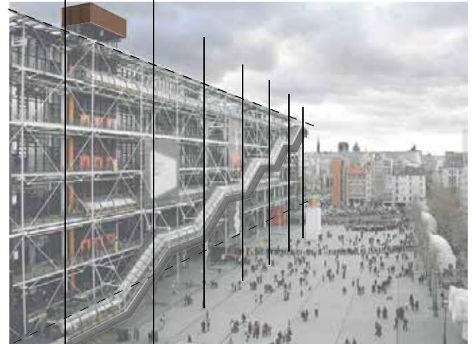
Volumetría expuesta del centro Pompidou.
