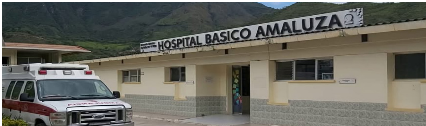
Imagen 1. Estado previo de la edificación antes de la intervención en la cubierta.
