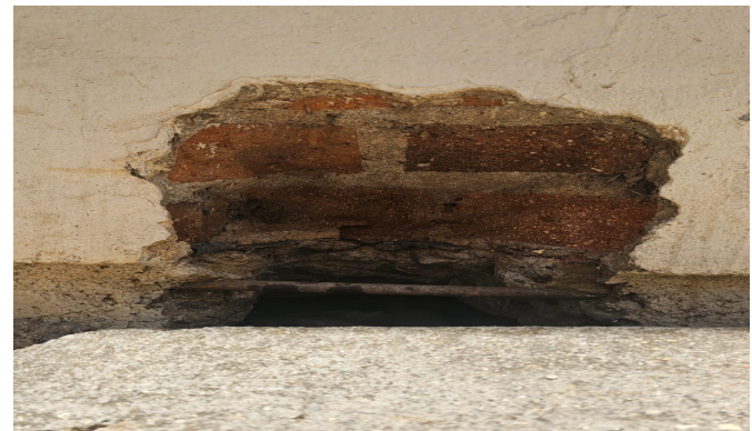
Imagen 11. Fachada con uso predominante de ladrillo en el sistema constructivo
