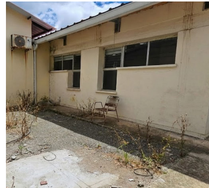
Imagen 10. Patio exterior del Hospital Básico de Amaluza sin uso funcional definido
