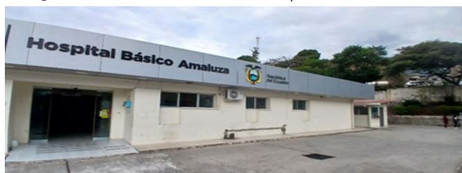
Imagen 2. Fachada frontal actual del Hospital Básico de Amaluzza.
