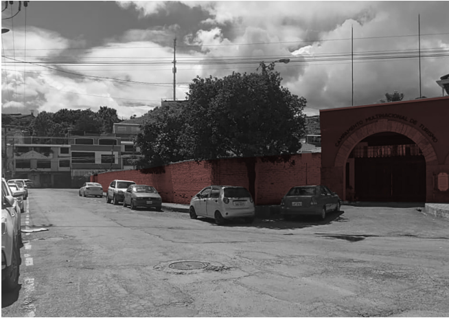
Figura 101. Fotografía de zona 1 de muros ciegos Elaboración: Propia (2025)
