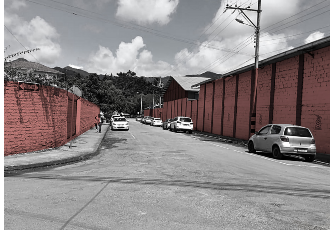
Figura 102. Fotografía de zona 2 de muros ciegos Elaboración: Propia (2025)
