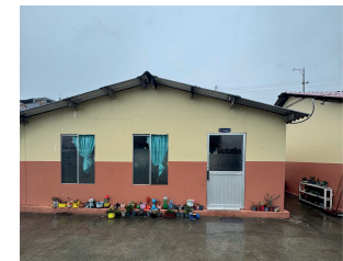
Figura 87 : Aula Prefabricada Autor: Elaborado por el autor, 2025
