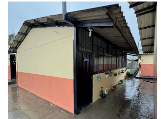
Figura 84: Aula Hormigón Autor: Elaborado por el autor, 2025
