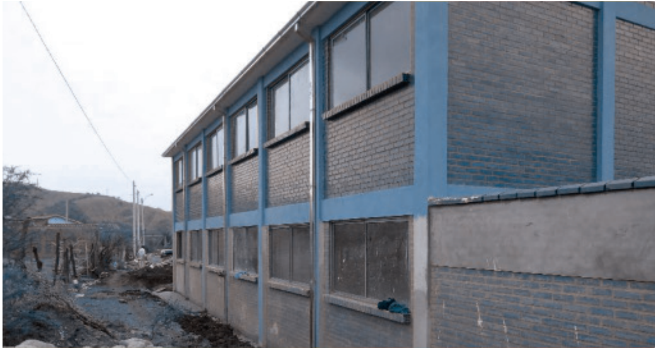
Figura 41: Edificación educativa - Bolivia Autor: Elaboración Propia del autor,2025
