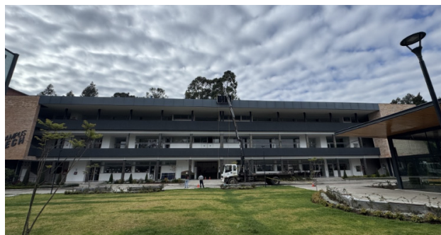
Figura 7: Edificio CEELA - Cuenca Autor: Universidad de Cuenca, 2021
