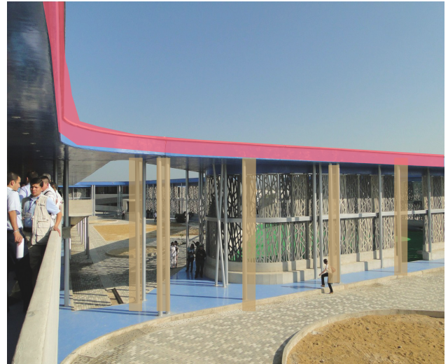
Figura 24. Fachada y envolvente
