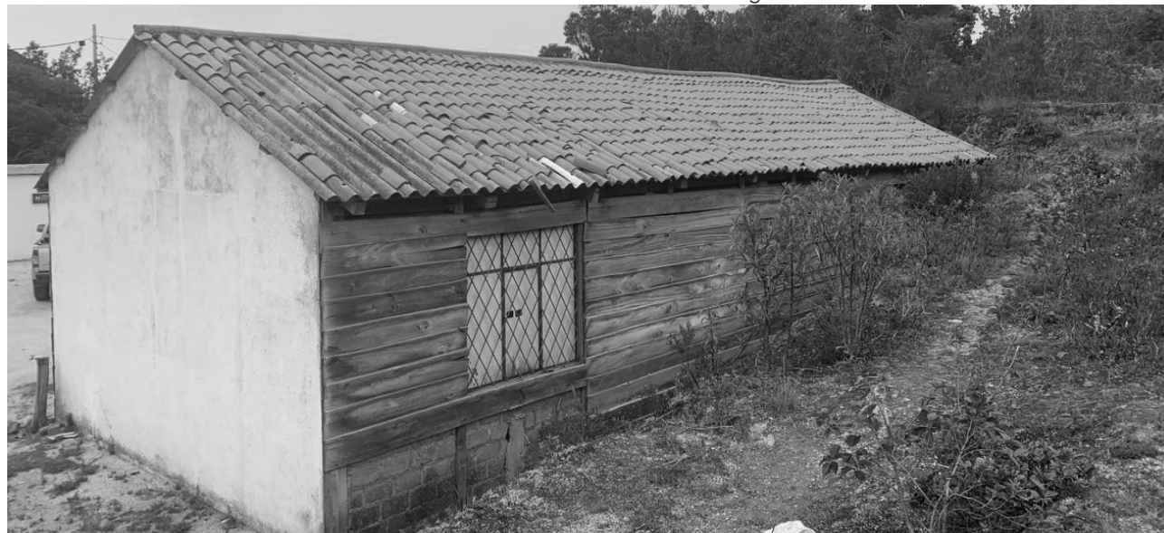
Figura 1. Infraestructura existente en desuso
