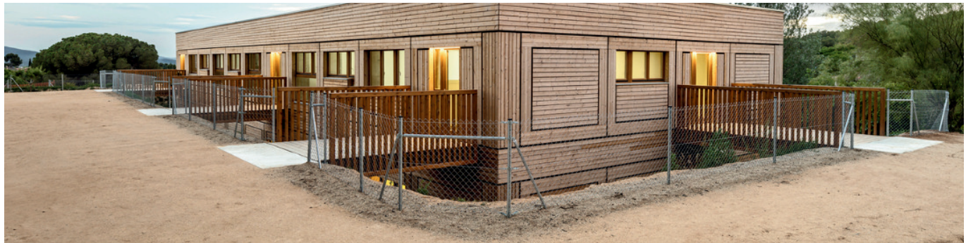
Figura 42. Forma de edificio vista lateral
