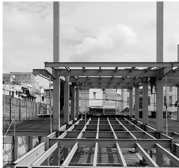
Figura 9. Estado actual de construcción - FRONTAL
