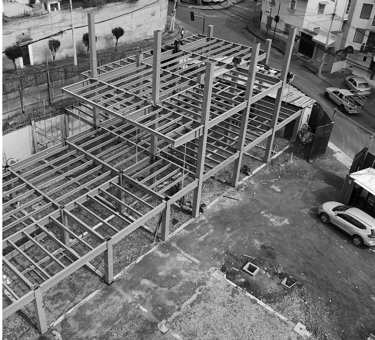
Figura 12. Estado actual de construcción - Toma Aérea
