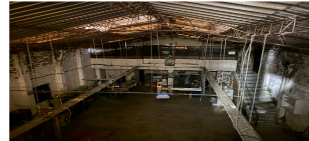
Ilustración 4. Galpón Industrial Interior, elaboración propia.
