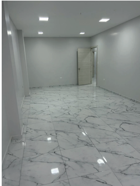
Figura 10. Estado Interior Autor. Plusvalia
