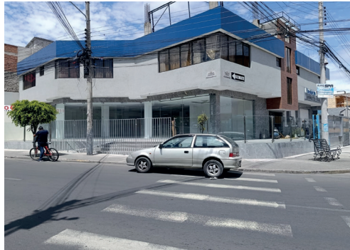
Figura 8. Construcción Actual Autor. Propio
