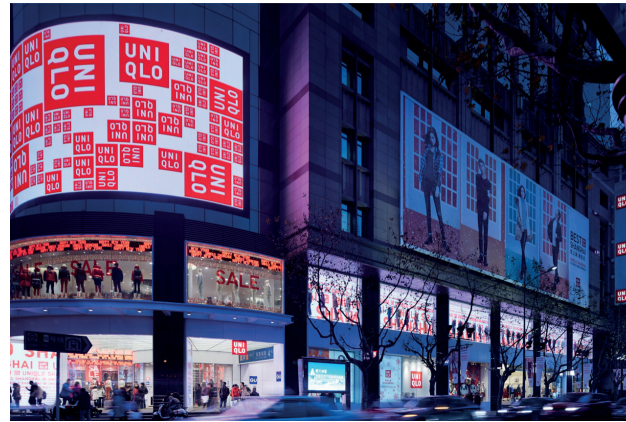
Figura 19. Tienda UNIQLO Shangai Autor. Nacasa & Partners Inc.
