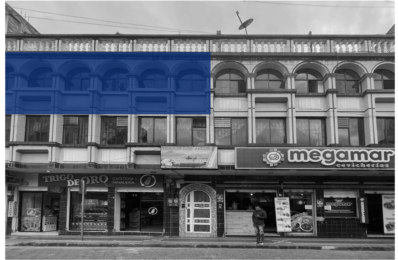
Ilustración 7 : fotografía Sara Cachimuel- Fachada estado actual
