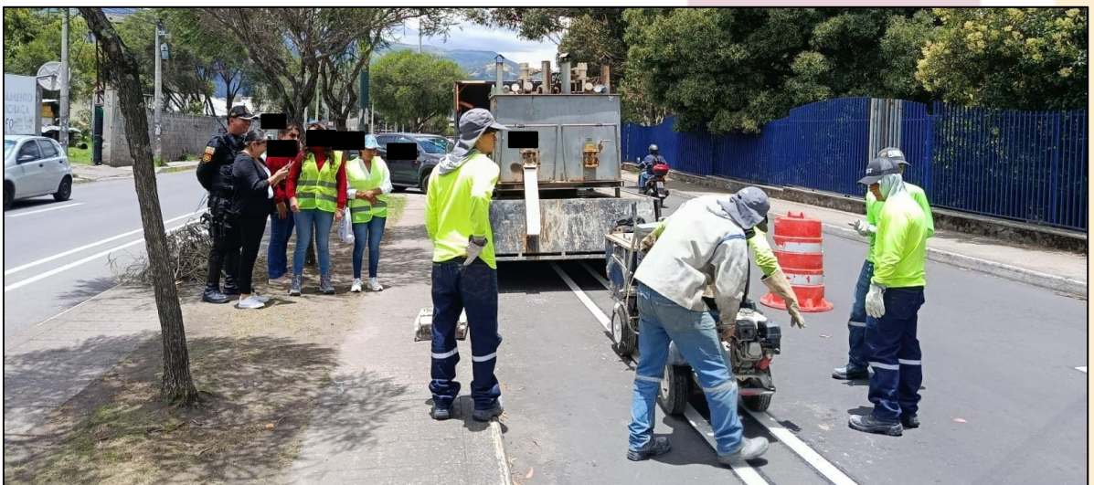
Fotografía 12 Inspección en campo.
