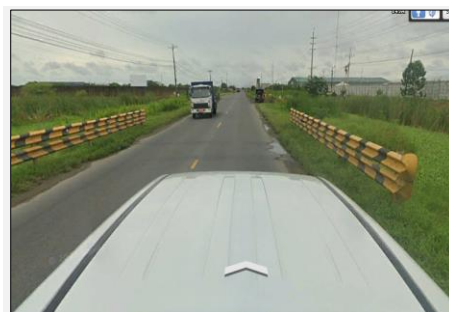
Fotografía: De conjunto, vista de zona de accidente.
