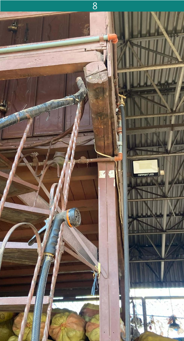
fendas y ensamble defectuoso
