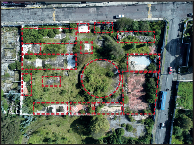
Vestigios de preexistencias: Organización de espacios para contener Aulas - Talleres Cancha
