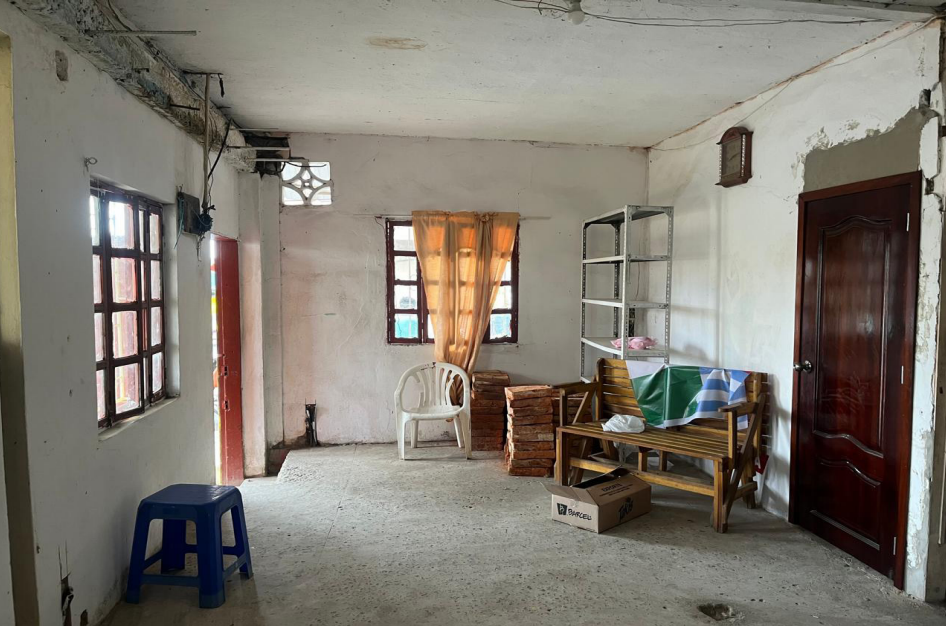
Figura 7: Estado actual interior del sitio de estudio. Fuente: Tomada por autor.
