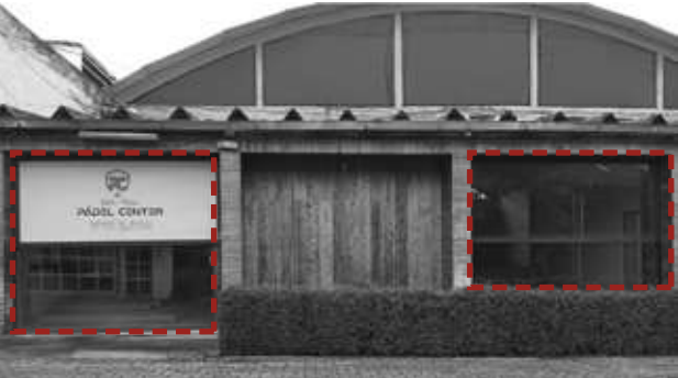
Fotografía 2. Fachada actual. Ronquillo, A. (2025)
