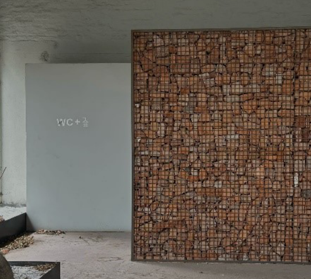
Figura 19 : Vista interna espacio a intervenir Fuente : Elaboración propia, 2025
