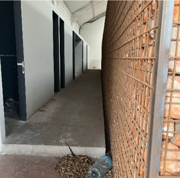
Figura 20 : Zona de baños sitio a intervenir Fuente : Elaboración propia, 2025
