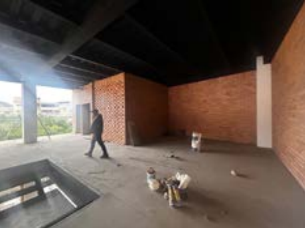
Fotografía 10, Planta alta, vista a servicios higiénicos
