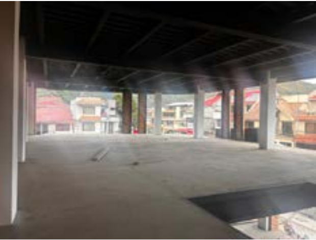
Fotografía 9, Planta alta, en construcción.
