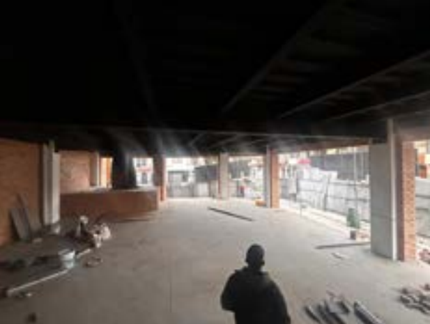
Fotografía 8, Planta baja, en construcción.
