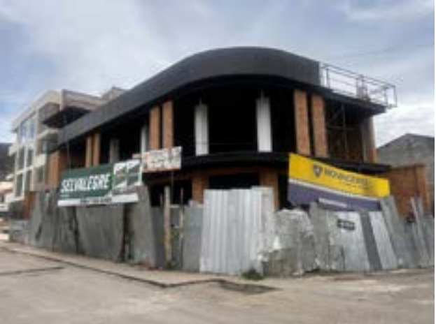
Fotografía 5, Ferretería Borja, local nuevo. Vista esquinera
