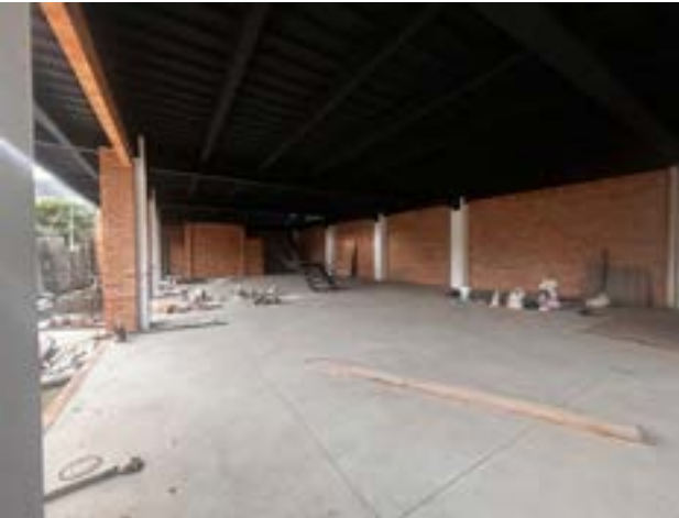
Fotografía 7, Planta baja, en construcción.
