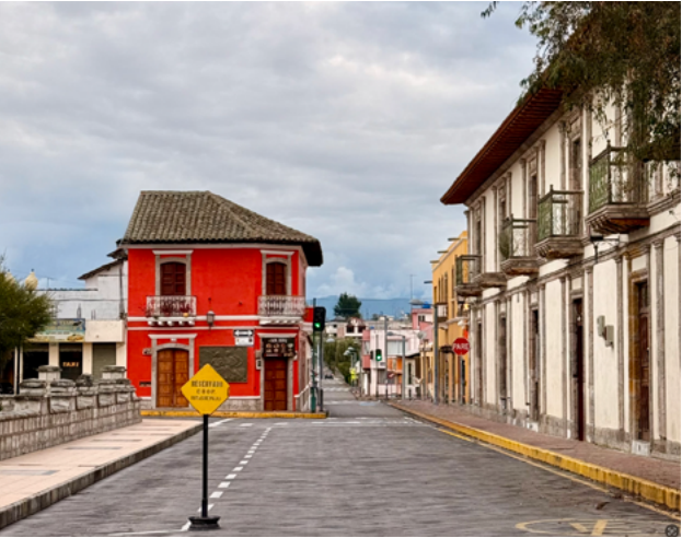
Figura 09: Fachada lateral derecha a intervenir, cantón Pujilí. Fuente: Elaboración propia.
