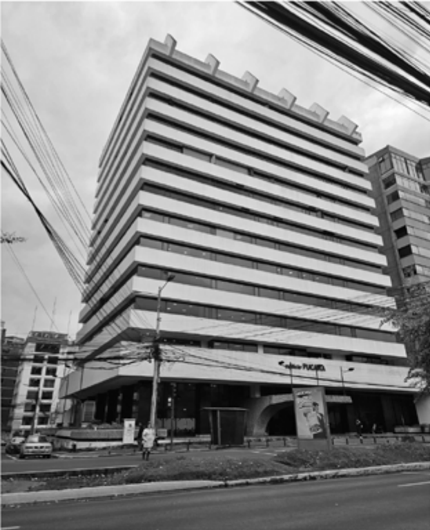
Fotografía 1: Edificio Pucará Autoría propia
