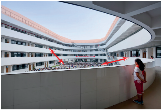
Figura 69. Pasillos de escuela Tiantai N°2
