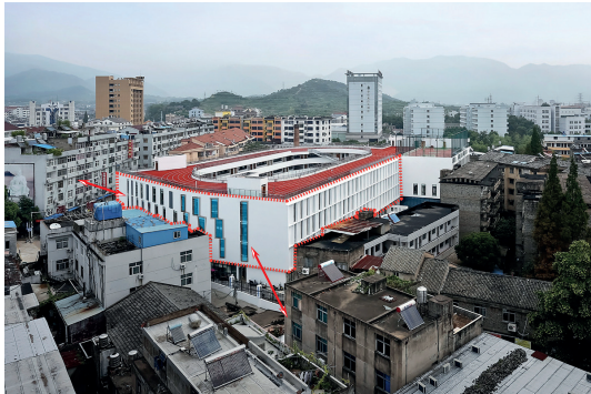
Figura 70. Fachada de escuela Tiantai N°2
