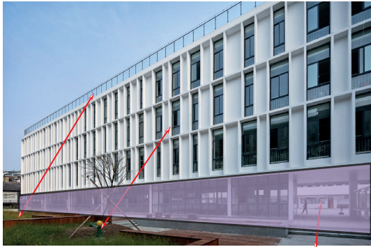
Figura 68. Fachada de escuela Tiantai N°2
