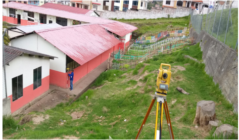
Figura 113. Pendiente sin tratar 2019
