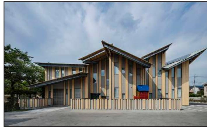
*Nota:* La cubierta inclinada permite una ventilación cruzada, mejorando el confort térmico del espacio. Adaptado de Kengo Kuma y Asociados (2025), en Japón.
