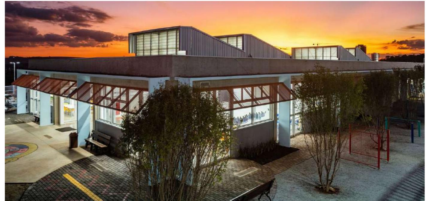
Nota: Las aberturas en la cubierta y las protecciones solares permiten el ingreso de luz y aire natural, mejorando el confort interior. Adaptado de GOAA - Gusmão Otero Arquitectos Asociados (2025).
