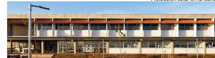
Nota: que las persianas retráctiles controlan la radiación solar y optimizan el confort térmico interior. Adaptado de GOAA - Gusmão Otero Arquitectos Associados (2025).
