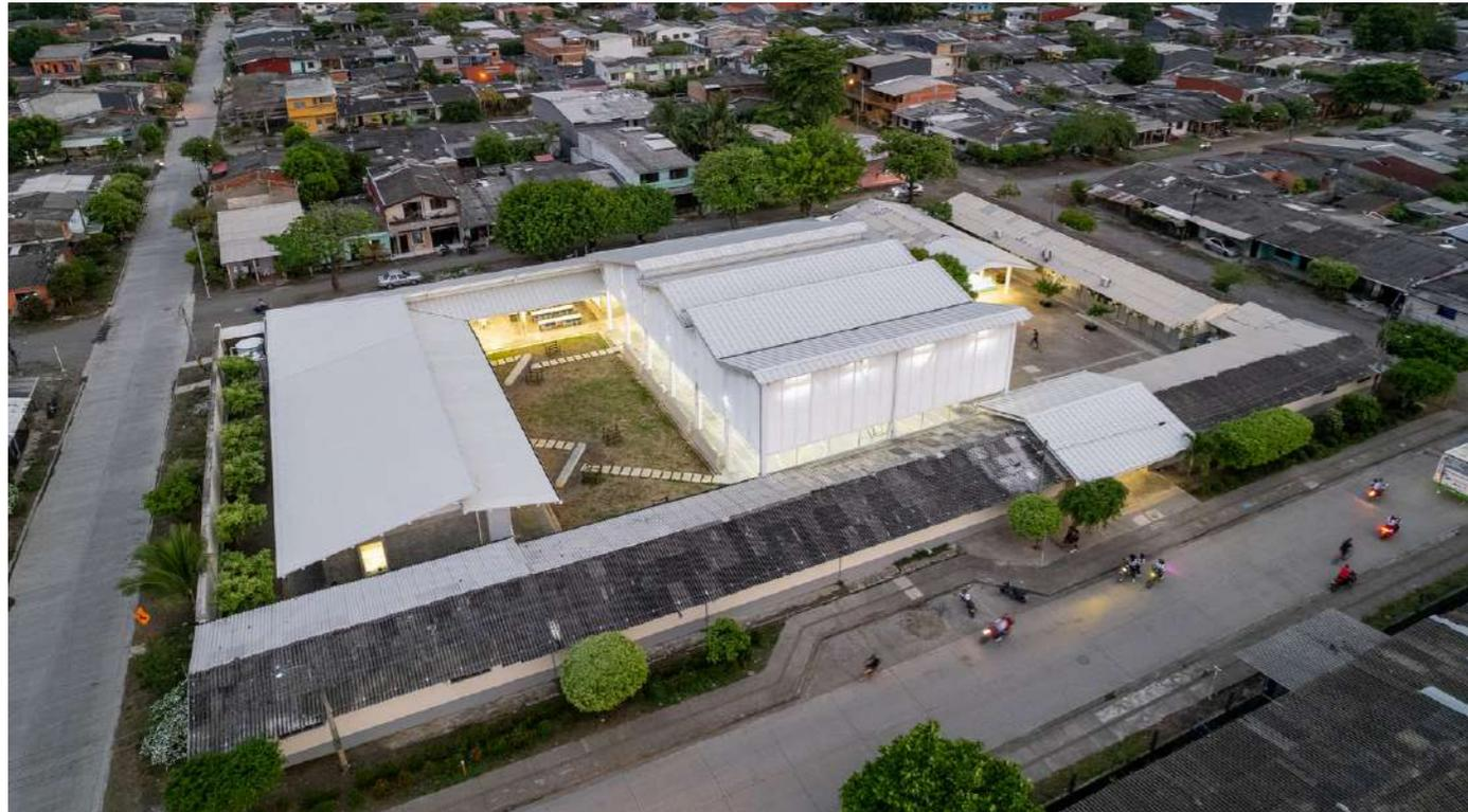
Nota: Las aberturas en la cubierta y las protecciones solares permiten el ingreso de luz y aire natural, mejorando el confort interior. Adaptado de GOAA - Gusmão Otero Arquitectos Asociados (2025).
