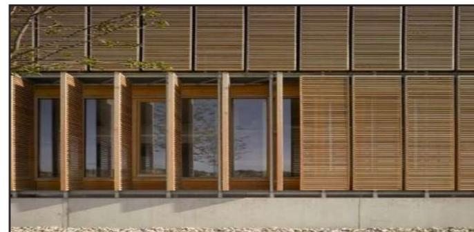
Nota: El uso de listones de madera móviles regulan la luz natural y optimizan la ventilación, combinando funcionalidad y estética. Adaptado por Kéré Architecture (2025).
