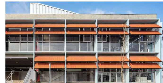
Nota: La fachada simétrica permite mayor ventilación e iluminación natural. Adaptado de GOAA - Gusmão Otero Arquitectos Associados (2025).
