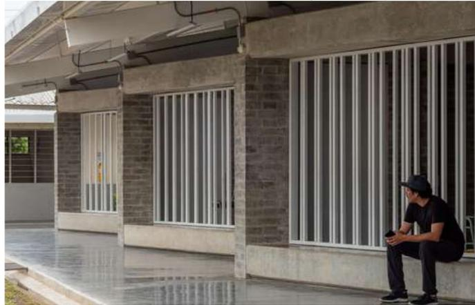
*Nota:* Las celosías permiten iluminación natural y ventilación cruzada, generando confort sin perder conexión con el exterior. Adaptado de Taller Síntesis (2025).
