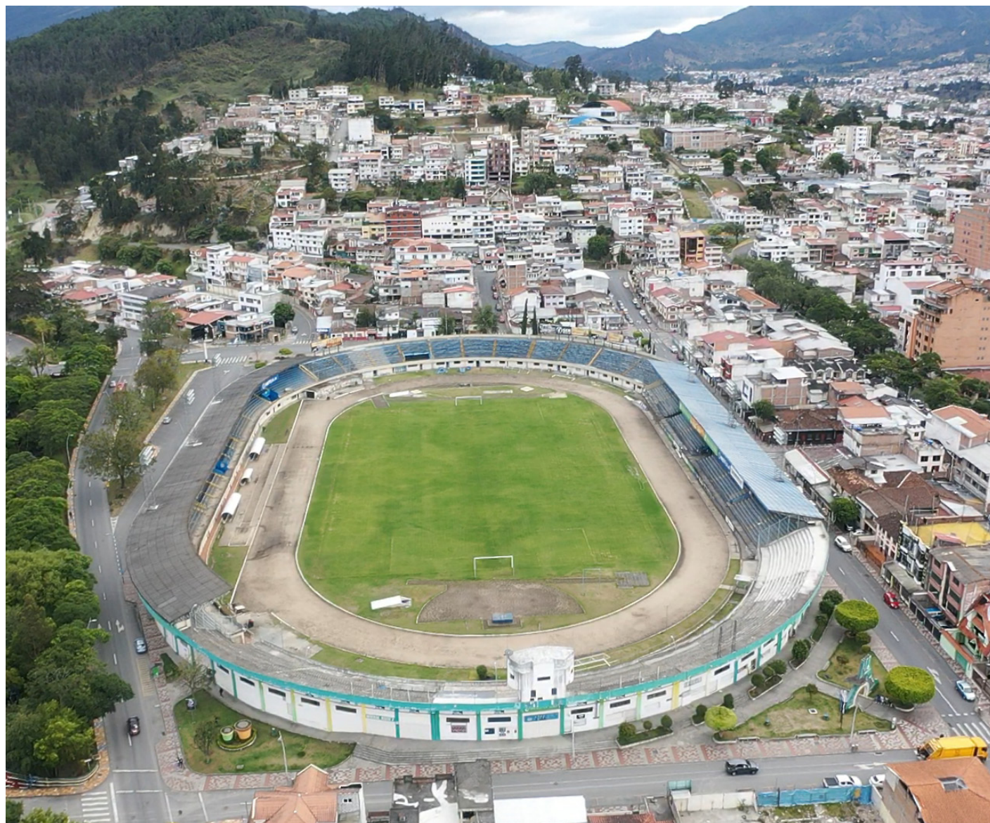
Figura 2: Vista aérea del Estadio Federativo Reina de El Cisne.
