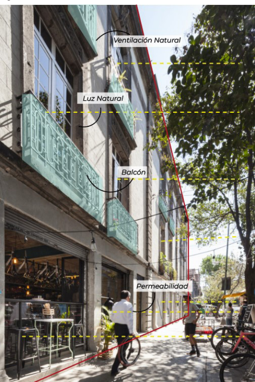
Figura 41. Relación Interior - Exterior de Balcón
