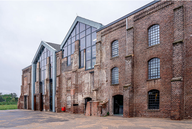
Figura 13. Edificio Monumental Greswaren
