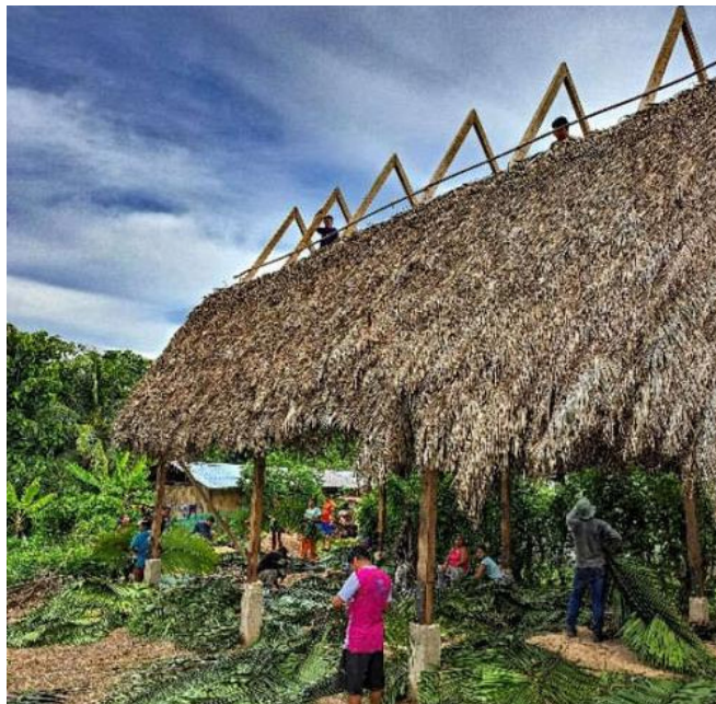
Figura 5. Construcción de estructura de madera con hoja de palma
