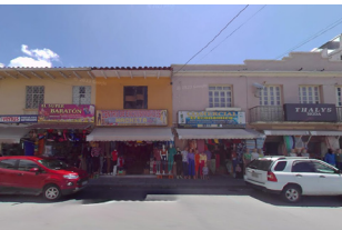
Figura 58. Fotografía viviendas uso mixto
