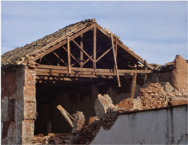
Figura 20. Cercha de madera para cubierta
