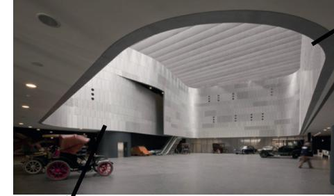
Los revestimientos interiores tienen paneles de acero perforado.
