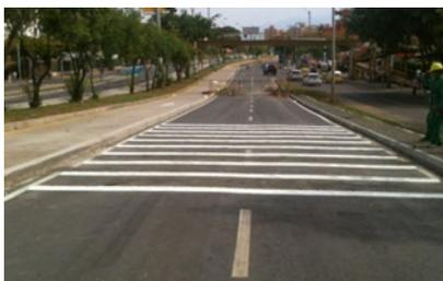
Bandas de alerta transversales con el objetivo de que los conductores disminuyan la velocidad en un segmento concreto de la vía.
