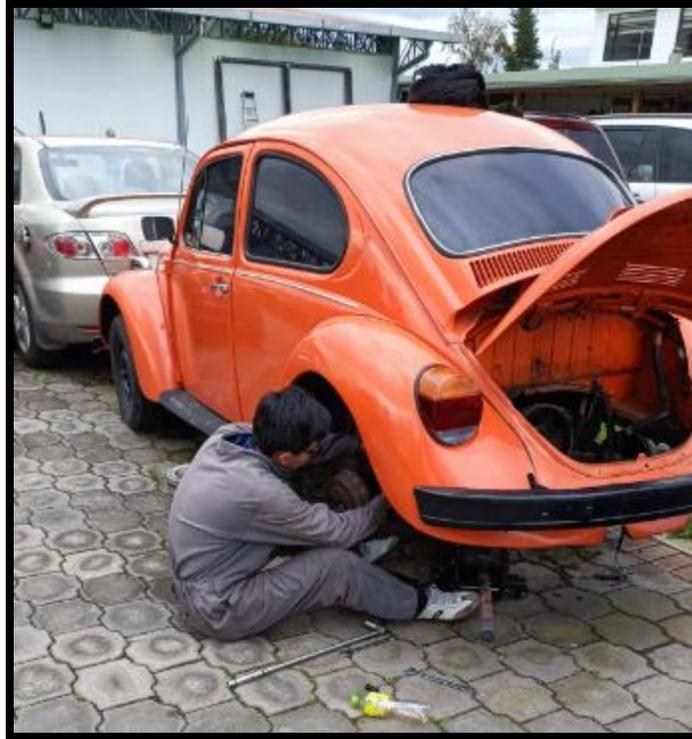
**Figura 4.8.1.5:** Desmontaje de línea de frenos
