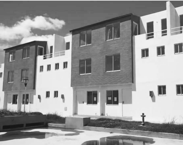
Imagen 14. Edificaciones de 3 a 4 pisos. Fuente: Munive, 2015.
