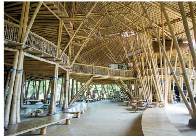
Figura 28: Bambu utilizado en las estructuras
