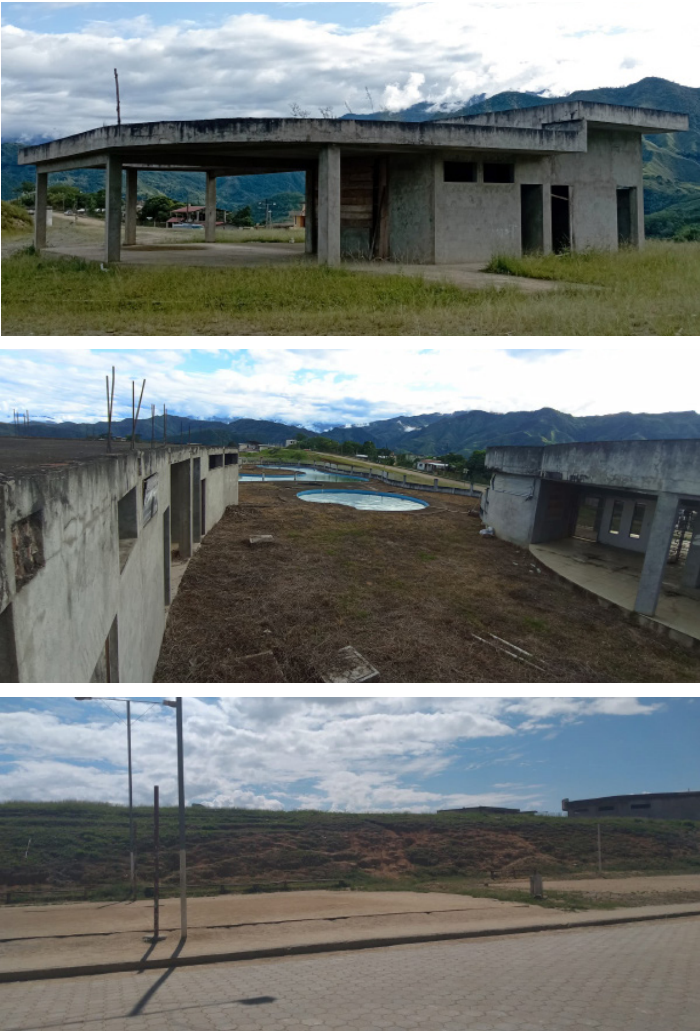
Figura 148, 149 y 150: Fotografías del estado actual de las preexistencias
