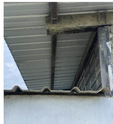
Ilustración 03. Falencias estructurales por precariedad en el mantenimiento.
