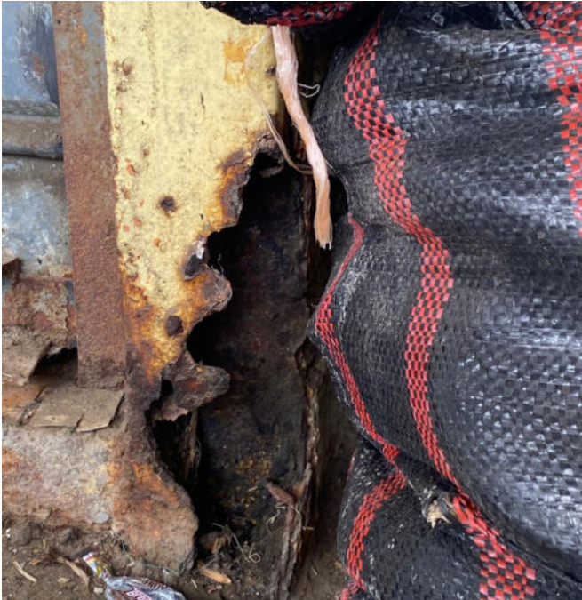
Figura 90 Fotografía de estructura actual
