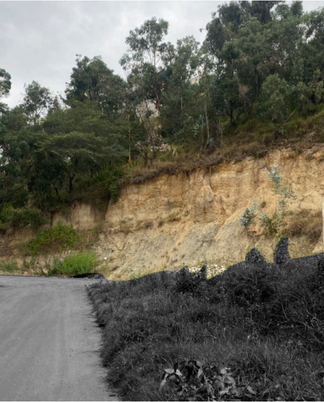
Figura 65 Fotografías de riesgos de deslizamiento de tierra
